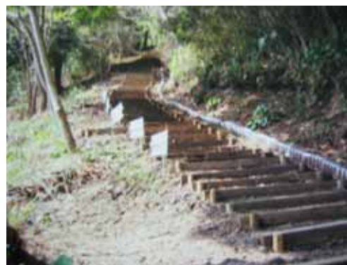
（完成した枕木階段）
