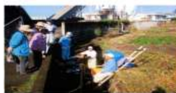
写真（7）水路に堰・浄化柵の設置
