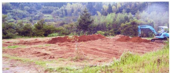
広場遊び場作り 工事の様子 2010.8.23撮影
