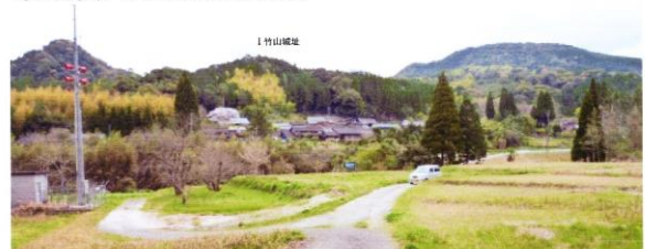
広場付近全景
