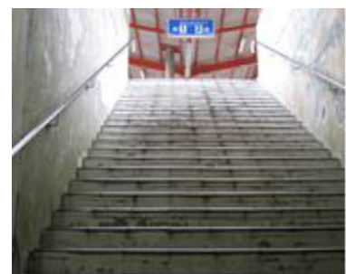
図 急勾配な階段の霧島神宮駅
