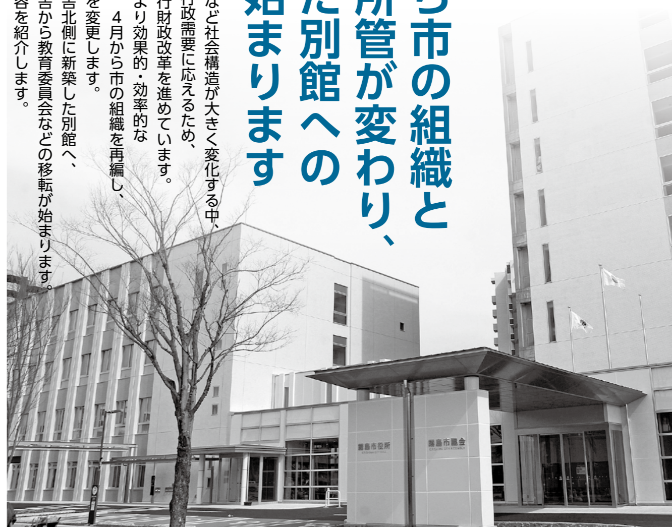
市役所国分庁舎(写真右)と北側に新築した別館(写真左)
