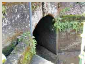
発電所付近にある取水口
