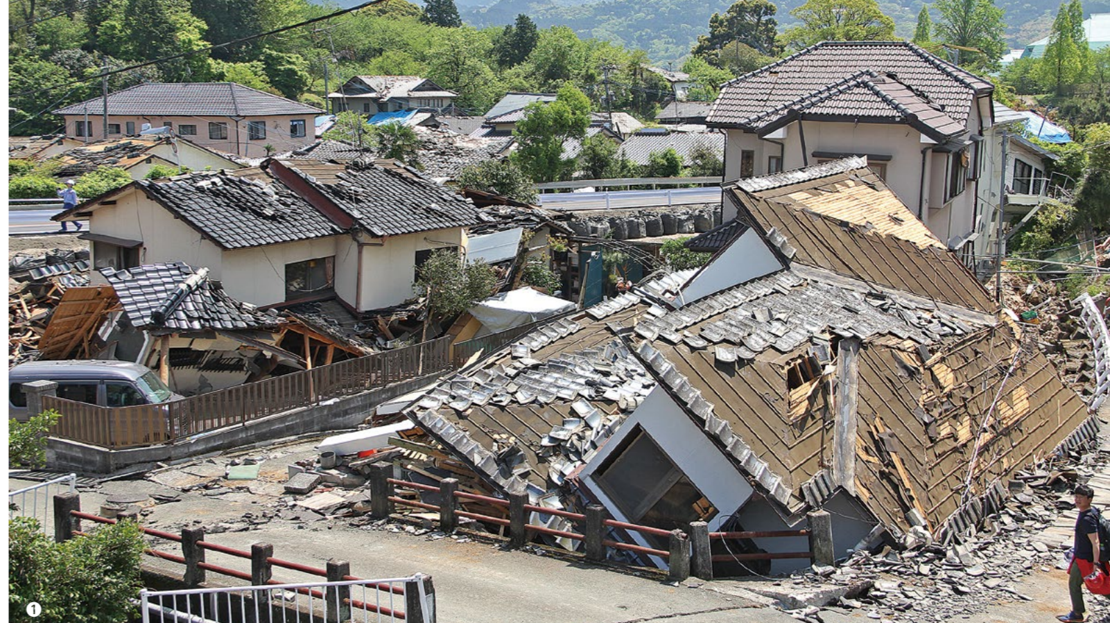
①地震で倒壊した無数の家屋 ②各地にあふれるごみの山 ③多くの道路や橋が破損し、交通に支障が出た ④1階部分が完全につぶれた家屋
