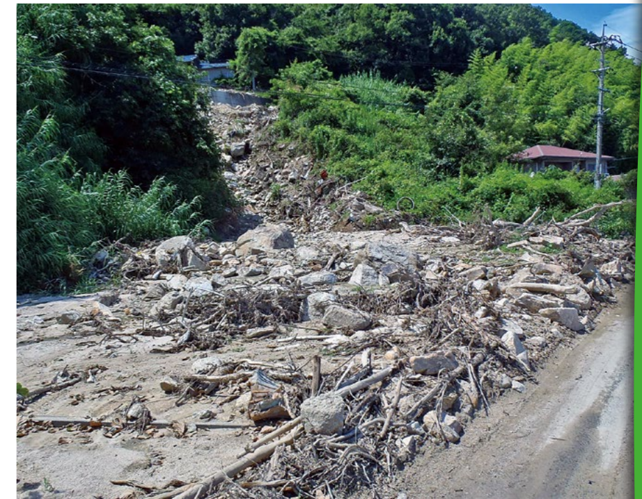
平成30年7月豪雨に見舞われた広島県江田島(えたじま)市の被災現場。幸い右奥の家屋は土砂にのみ込まれずに済んだ(写真は同市より提供)
