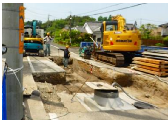
圧力管の新設工事現場
