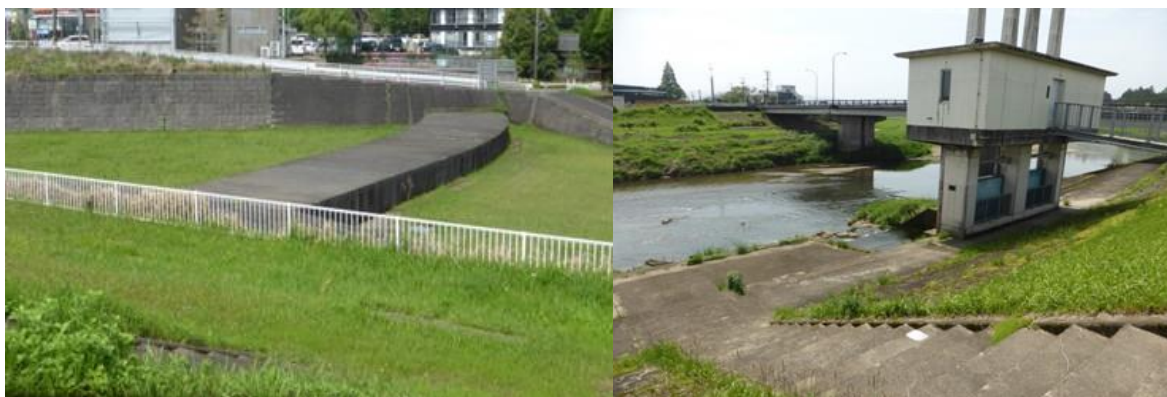
圧力管と調整池、排水先
