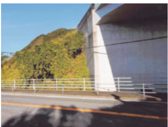
高速道路沿いの法面状態
