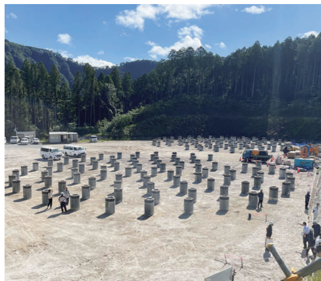
(仮称)宇都良配水池杭基礎工事
