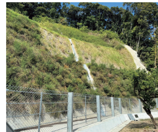
県単急傾斜地崩壊対策工事
