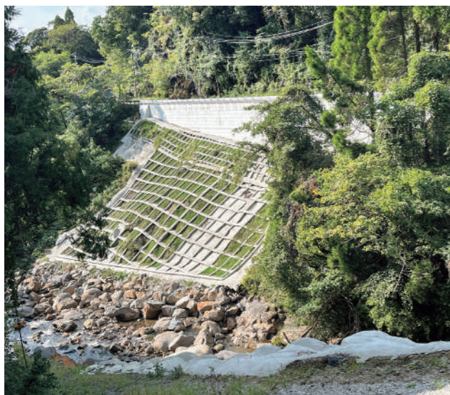
4災第234号 牧園～湧水線道路災害復旧工事
