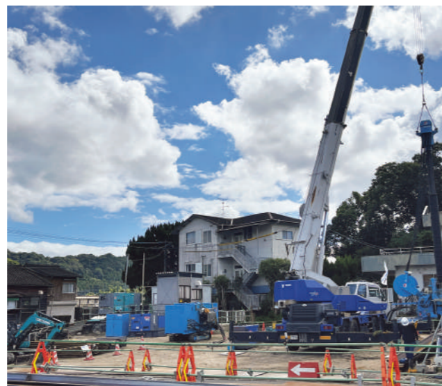
姫城地区排水機場建設工事
