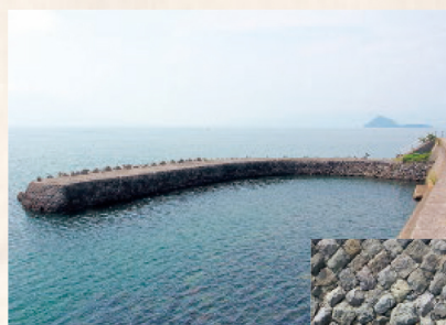
当時の面影を残す小村新田水門。国分広瀬の国分隼人クリーンセンター南側堤防にある
