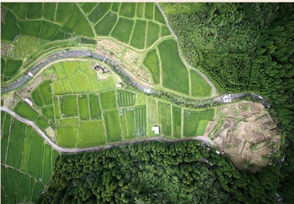
復元図と合致する遺構の航空写真（県立埋蔵文化財センター提供）
