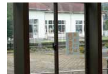
飛散防止フィルムを貼った窓ガラス
